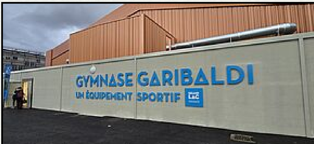
Gymnase Garibaldi photographié par Pierre Ledard janvier 2026.
