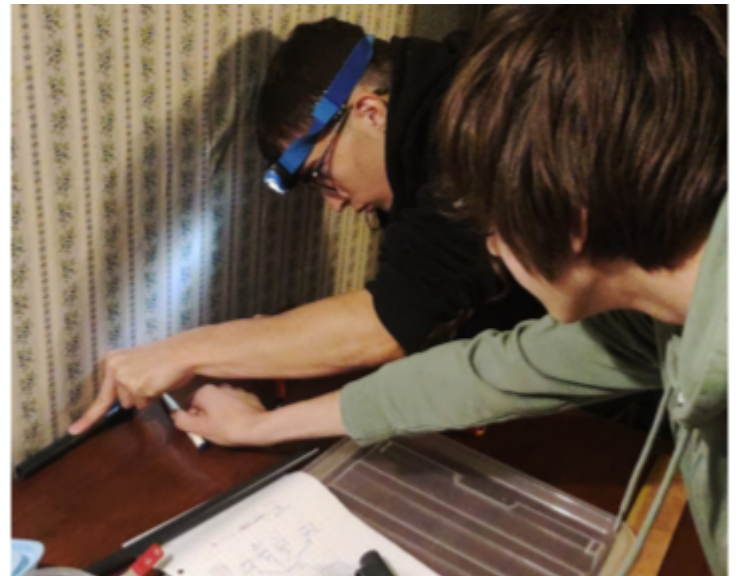
Marquage des emplacements des trous sur un tuyau
