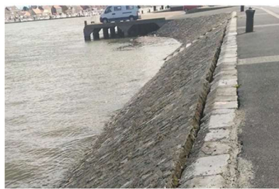
Figure 20 un perré (Source : https://www.deltafm.fr/info-locale/region/cote-dopale/elus-de-cote-dopale-reunis-renforcer-digues-eviter-catastrophe-demain )
