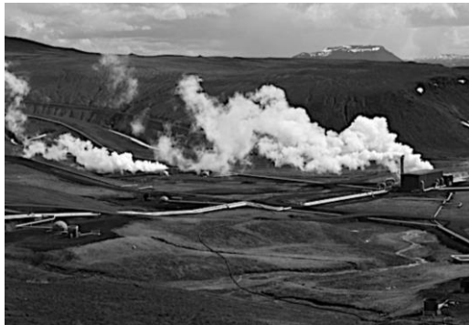
DOCUMENT 29 : Une usine géothermique en Islande. Les conduites forcées conduisent l'eau vers la centrale.
