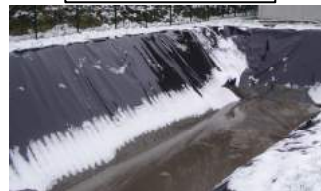
Bassin eaux pluviales
